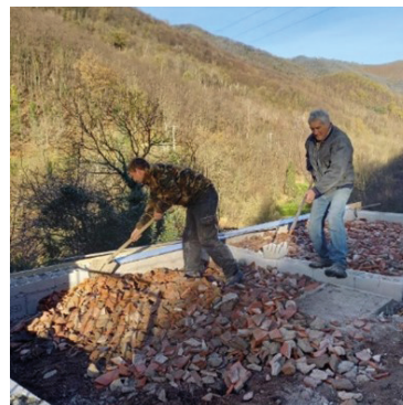
Chantier : préparation des plateformes.
