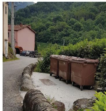
Installation de l'abribus et pose des containers pour les déchets & le tri sélectif.
